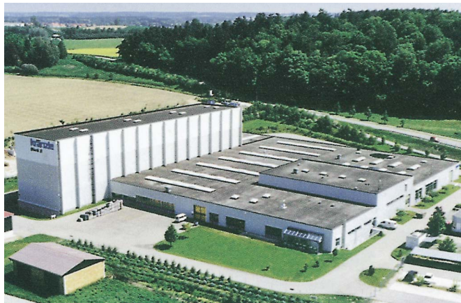
▲イラテッセン第2工場
